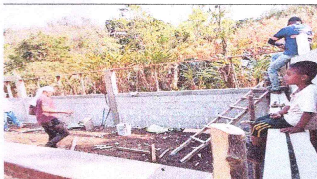
Foto 4: se identifica el avance de colocación de columnas de fundición de concreto
