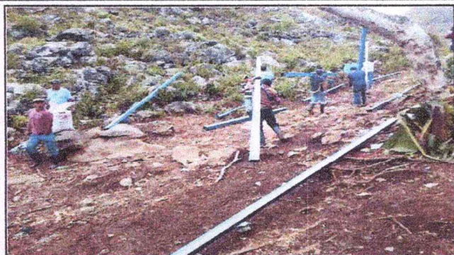
Foto 1: Se evidencia el proceso de traslado de soporte de la estructura del techo de la cocina
