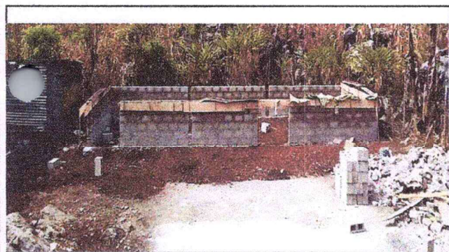
Foto 3: el avance de la instalación de U de concreto para un trabajo seguro y estable
