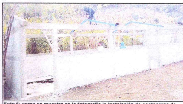
Foto 6: como se muestra en la fotografía la instalación de costaneras de soporte de la estructura
